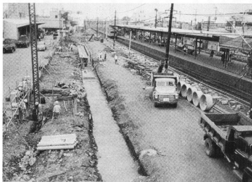
中央線複々線工事 昭和40年9月(松原義氏提供)
