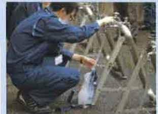
▲仮設の蛇口による応急給水
