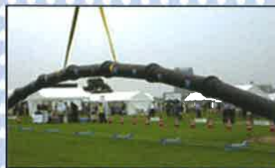
▲耐震継手管を吊り上げた様子
